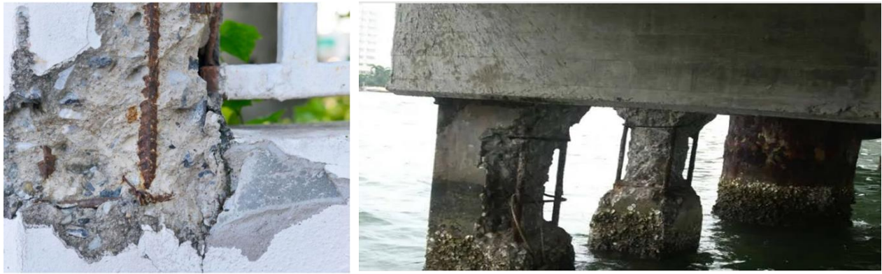
Figura 4.11. Muestra de Corrosión
