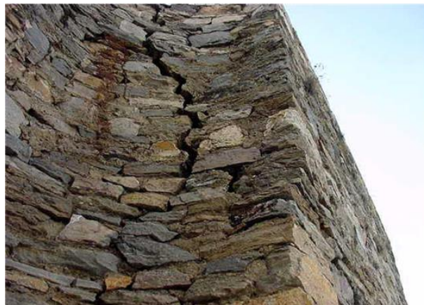
Figura 4.12. Fallas por sulfatos
