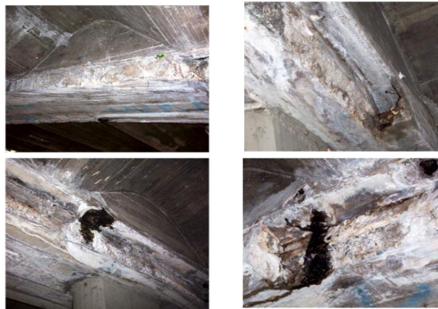
Figura 4.9. Fallas por carbonatación
