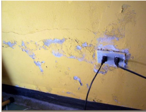
Figura 4.15. Humedad ascendente
