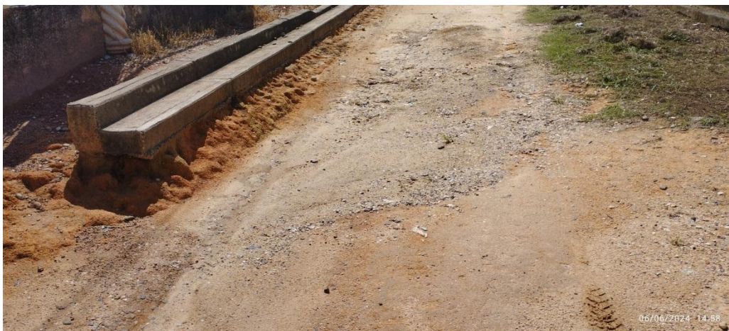
Socavación de Brocal
