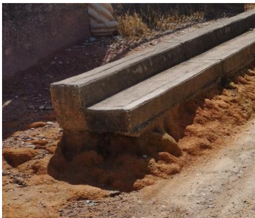
Figura 5: Brocal en Socavación
