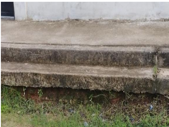
Figura 6: Acera en Socavación
