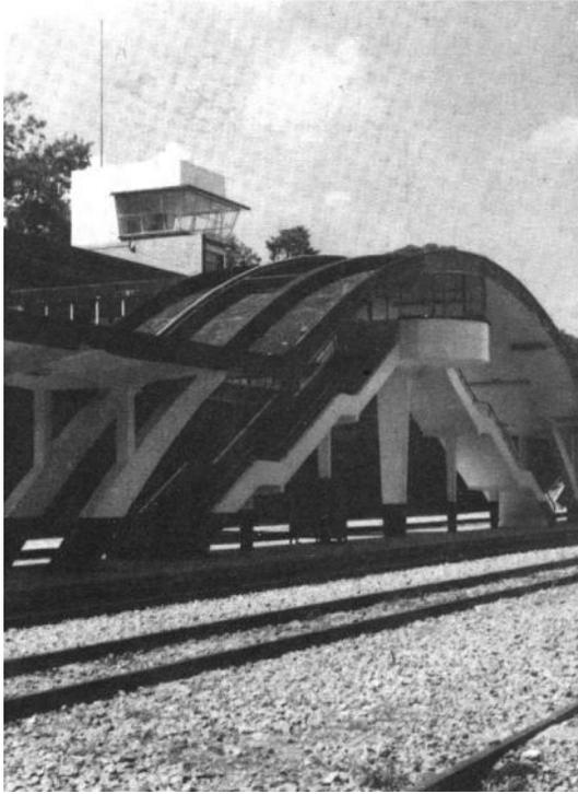
Puente de comunicación hacia los andenes de la estación del ferrocarril de Xalapa. En el primer plano se aprecian las escaleras soportadas por columnas y la original solución de la cubierta de concreto en forma curva que se articula con el cuerpo de llegadas y, más atrás, una torre de control que se eleva por encima de los edificios. Tomado de Robledo Landero (1996: 4).
