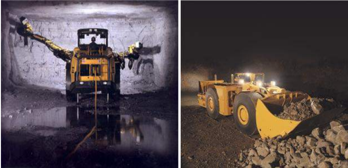
A la izquierda, Jumbo perforando con sus dos brazos articulados (visto desde atrás); a la derecha, equipo LHD en operación de carga (imágenes 3,4 ).
