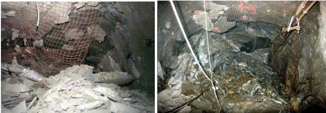
Casos de explosiones de roca ( rockbursts ) en galerías de minas subterráneas (imágenes 5,6 ). Oyarzún y Oyarzun (2011).
