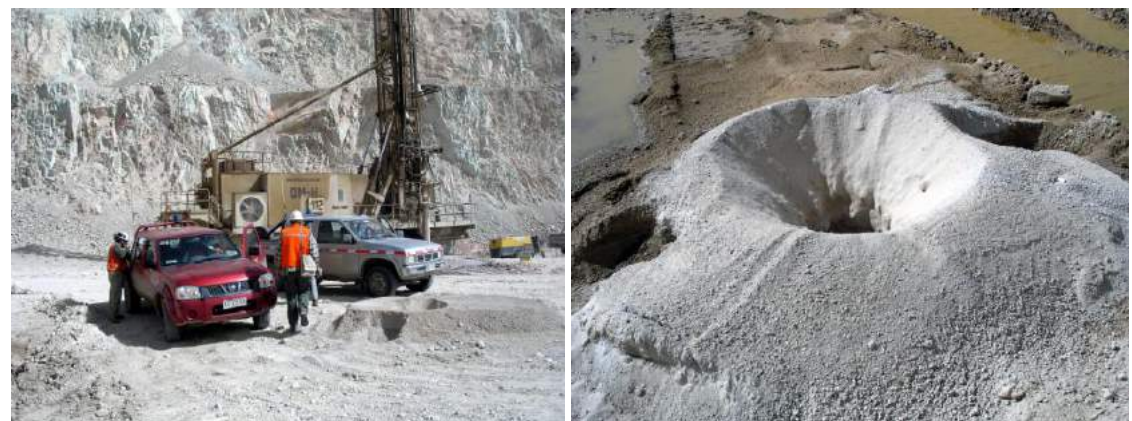
Preparación de un banco para voladura. A la izquierda, perforadora; a la derecha, hueco de perforación (Mayo de 2006).
