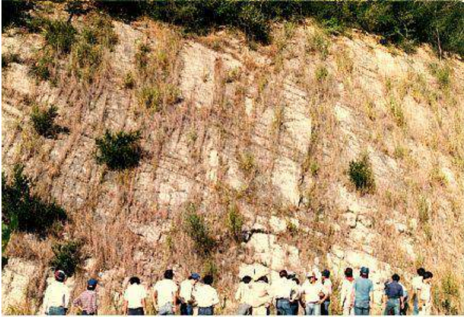
FIGURA 6.17. Fracturas abiertas en la Formación San Felipe del Cretácico Superior en el flanco suroriental de la Sierra de La Silla, al sureste de Monterrey, Nuevo León.
