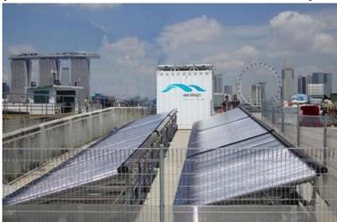
Figura 1.5.3 Destilador de cascada
