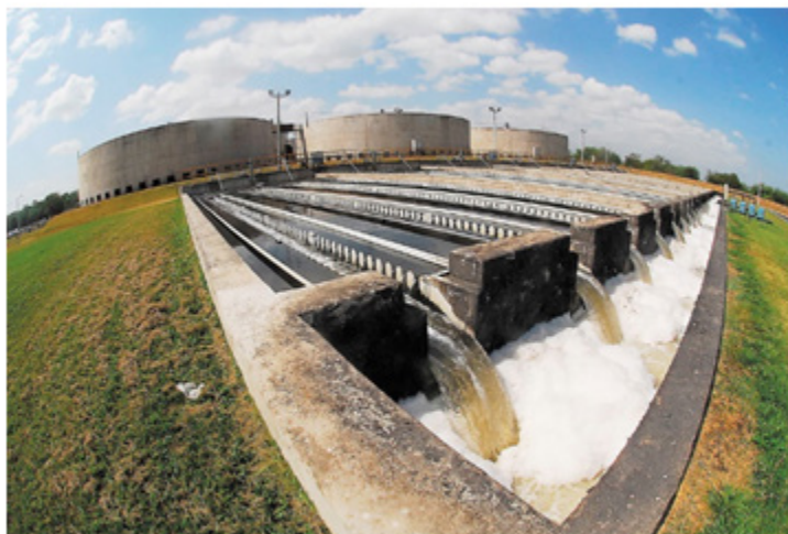
Fig.26. Planta de tratamiento de aguas residuales ubicada a orillas del Lago Xolotlán . Esta planta tiene la capacidad de procesar hasta 180 mil m 3 por día. Fuente: http://goo.gl/GOaugc
