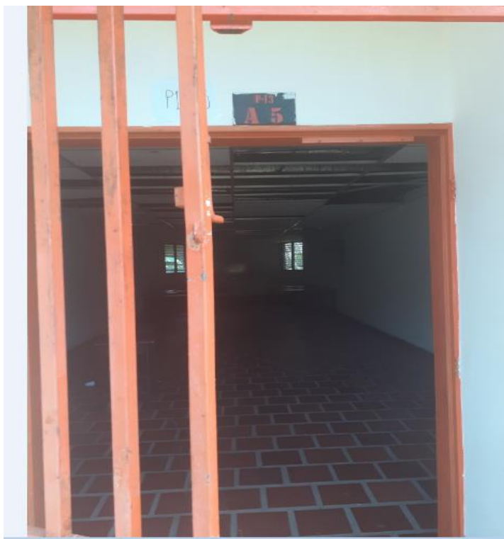
Condiciones físicas Aula 5, pabellón 13. Barinas II
