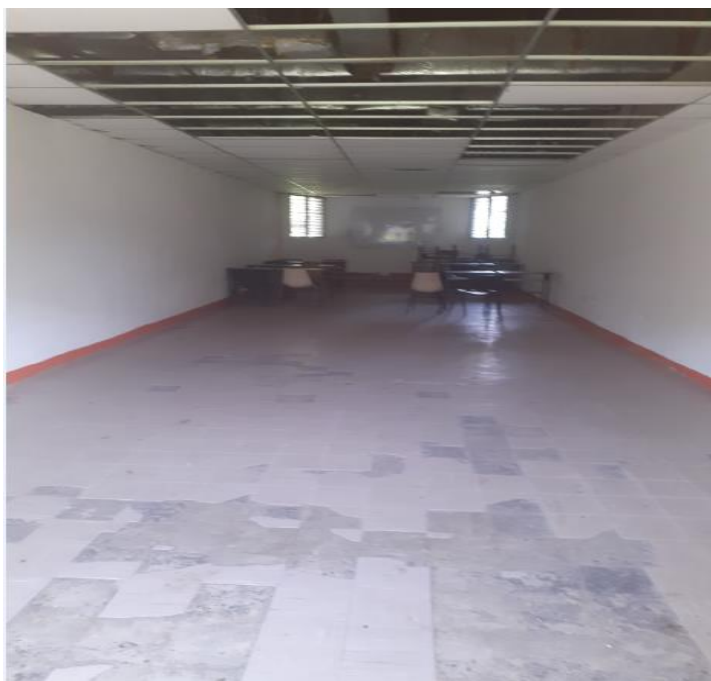
Condiciones físicas Aula 3, pabellón 13. Barinas II
