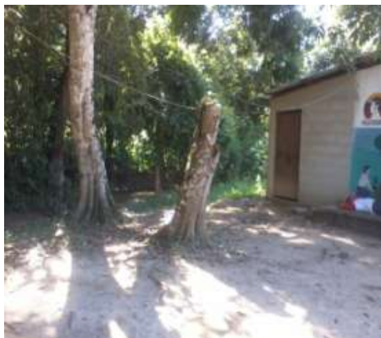
Figura 5. Vivienda construida a orilla de la quebrada Palambra, sector Palambra del doctor.
