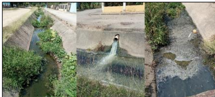
Figura 8. Desagüe de aguas residuales en el tramo D-E.
