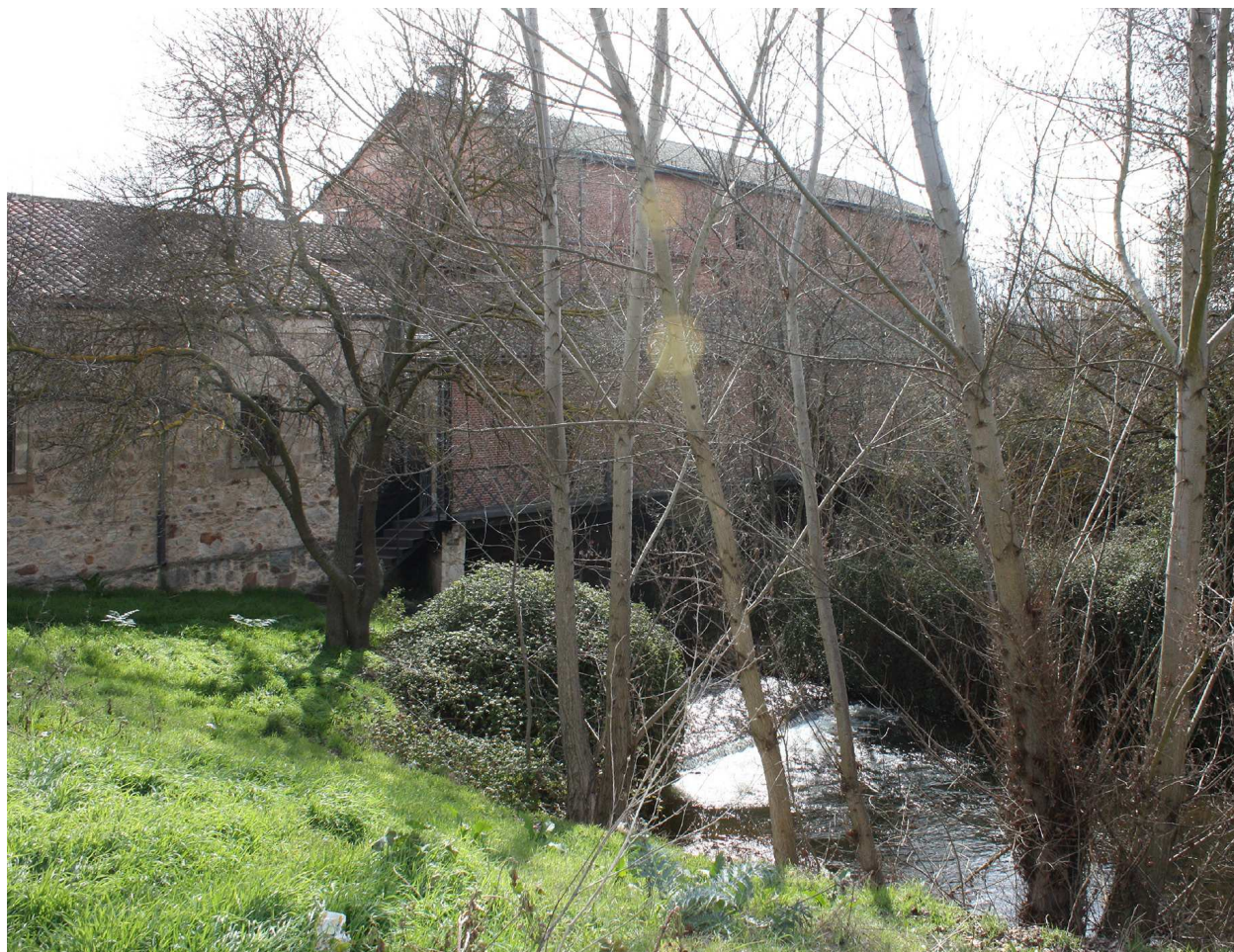
Figura 6. Estado actual del edificio de la Fábrica de Harinas El Sur (fachada interior, fotografía de C. Hernando).
