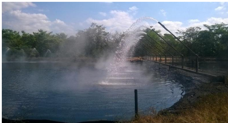
Figura N° 5. Laguna de enfriamiento Estación Sinco D, Barinas.
