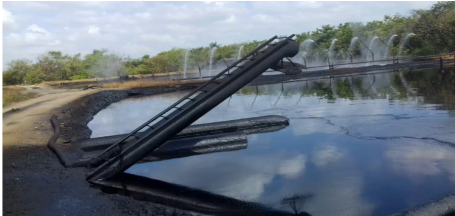
Figura N° 28. Laguna de enfriamiento estación Sinco D.
