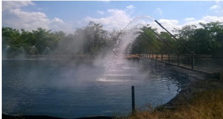
Figura N° 5. Laguna de enfriamiento Estación Sinco D, Barinas.
