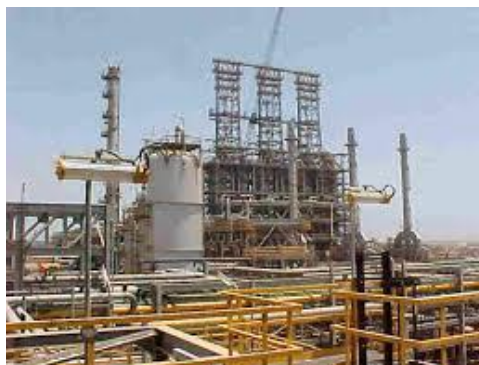
Figura 8. Equipos de procesos de un mejorador de crudo
