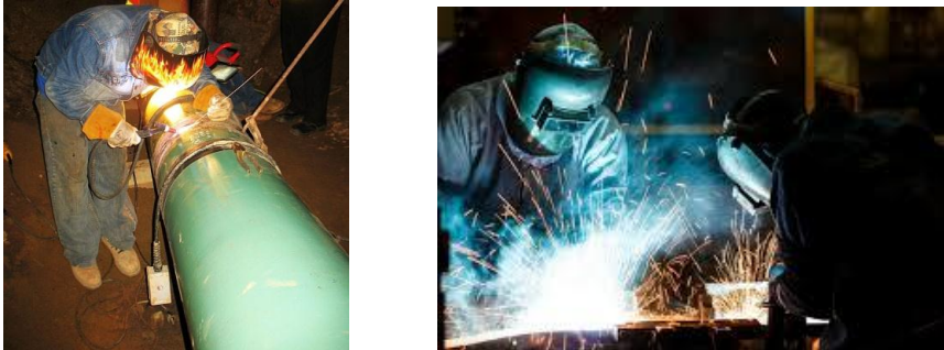
Figura 2. Vista general del trabajo de soldadura
