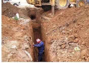
Figura 3. Trabajo de excavación con medición de profundidad.
