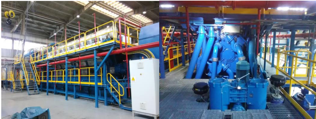
FIGURA 10: MOTOR WARTSILA, Planta de generación a diesel Wartsila
