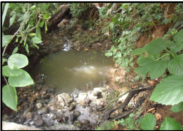
Foto; 5, 6 y 7 Revisión de la quebrada “El Perico“, donde muestra su naciente y gran cantidad de desechos sólidos como factor contaminante; así como desembocadura del tubería de cloacas que permiten el suministro de aguas servidas y son focos contaminantes para las especies que allí coexisten.
