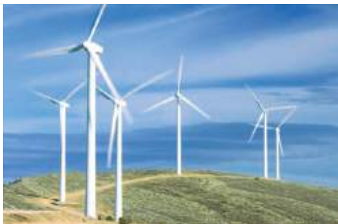
Figura 3.43 En Oaxaca, inicialmente, funcionaron siete aerogeneradores de electricidad en La Venta.
