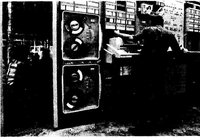
Fig. 37-12. Instalación de un sistema de conmutación automático electrónico (American Telephone and Telegraph Co.).
