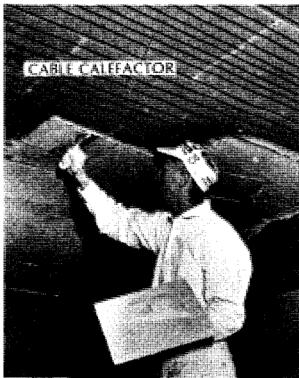
Fig. 33-3. Instalación de cable y radiador de calor (L. N. Roberson Company).
