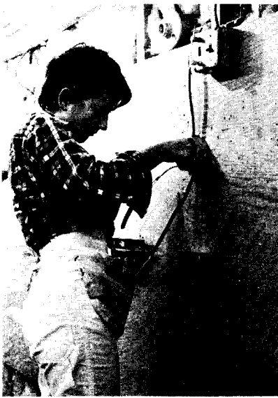
Fig. 5-9 Un electricista de la construcción alambra una caja de conexiones eléctricas (Departamento del Trabajo de EE.UU.).
