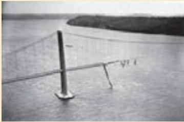
FIGURA 1 Colapso del puente de Tacoma Narrows
