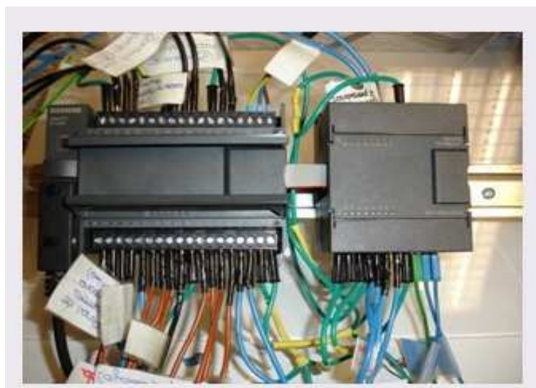
Figura 10: Autómata S7-200 utilizado
