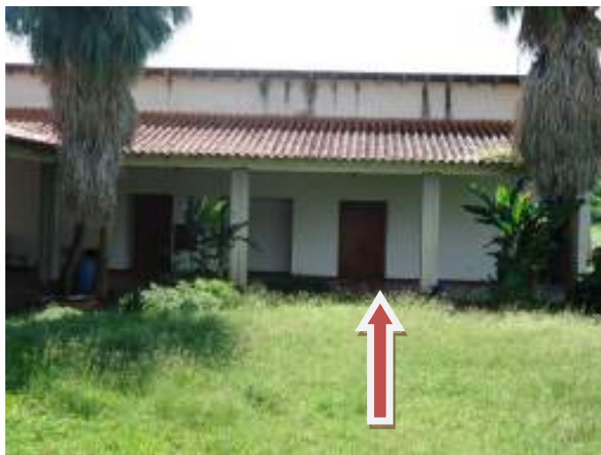
Fotografía 1. Vista frontal del aula (En edificio administrativo JBU)
