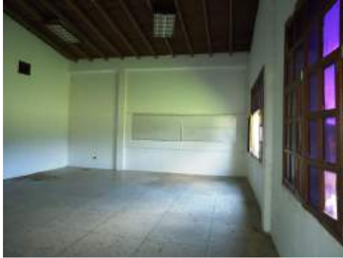
Fotografía 3. Vista interior. Aula
