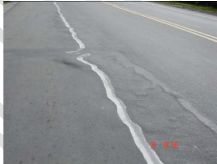
Figura N° 15: Cordón Longitudinal Fuente: Néstor Huamán y asociados
