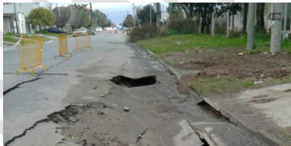
Figura N° 13: Hundimiento Fuente: Néstor Huamán y asociados
