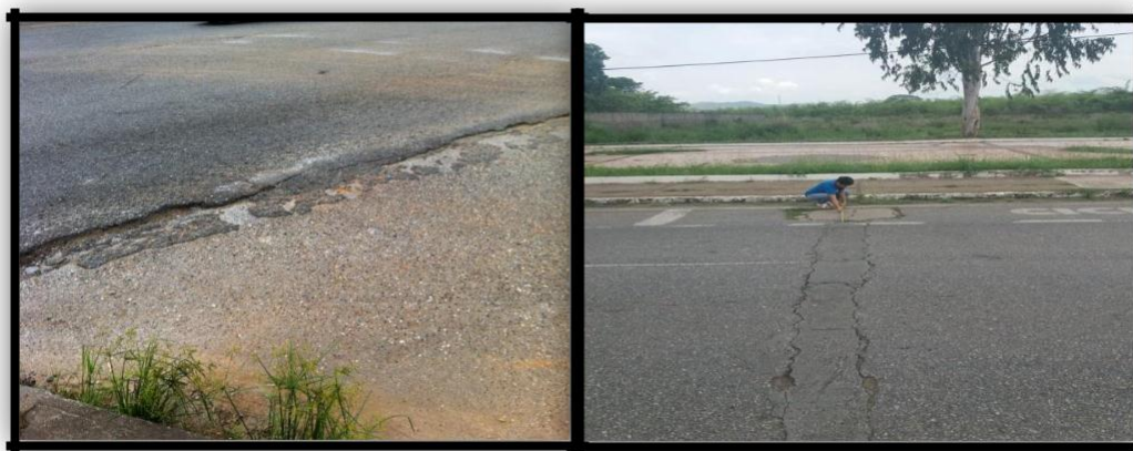
Fig. N° 36: Fallas estructurales presentes en la carpeta de rodamiento Fuente: Moreno y Leon (2019)
