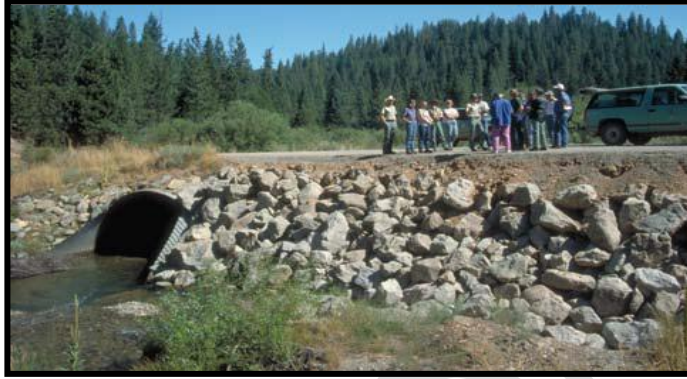
Figura N° 9: Alcantarilla Fuente: Romero y Tagliaferro (2008)
