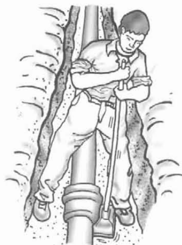
Apisonado de los lados de la cama de apoyo
