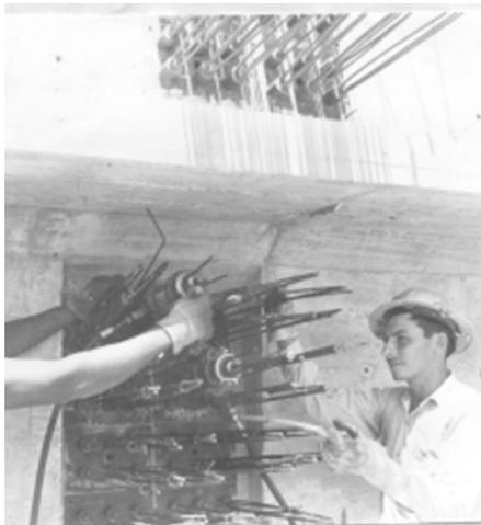
Figura 9. Tensado de cables de viga. Tensado de los cables antes de la colocación en su sitio en el puente.
