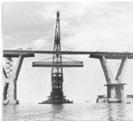
Figura 11. Colocación de vigas. Nuevas vigas colocadas con la grúa principal “El Ajax”.
