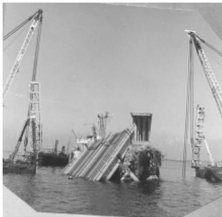
Figura 7. Tramo caído. Una mesa de la pila caída y apoyada en la proa del banquero.
