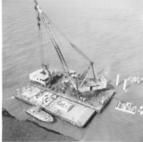
Figura 6. Grúa Puerto Cabello. Esta grúa fue usada para sacar los escombros.
