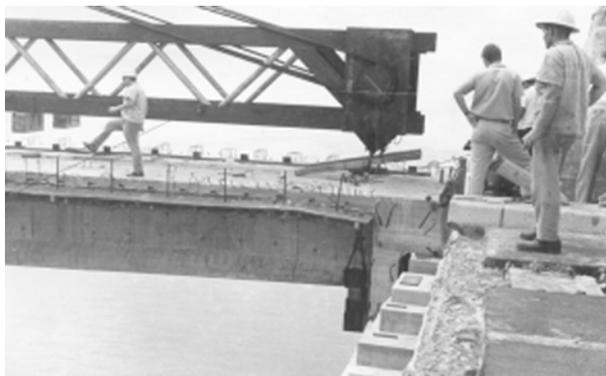
Figura 12. Viga apoyada. Momento en que se está colocando la viga sobre el apoyo.
