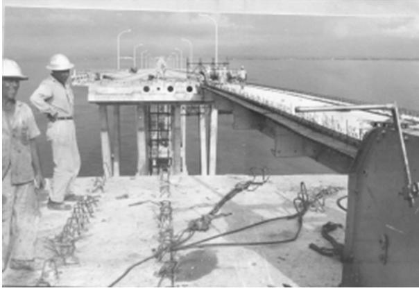
Figura 14. Reconstrucción de tramos. Vista de viga colocada durante la reconstrucción.
