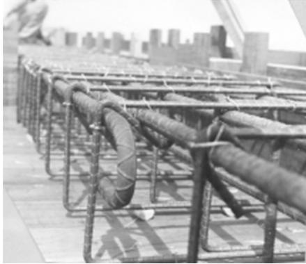
Figura 8. Armadura. Vista en detalle de la armadura de una viga.
