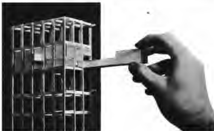
4.2. Le Corbusier, maqueta del sistema modular de la Unidad de Vivienda de Marsella, 1947.
