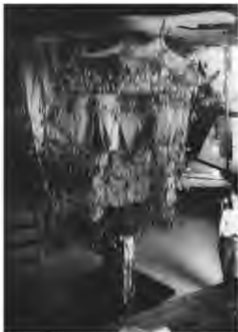
4.12. Antonio Gaudí, maqueta de cargas y esfuerzos de la iglesia de la colonia Güell, 1898-1904.
