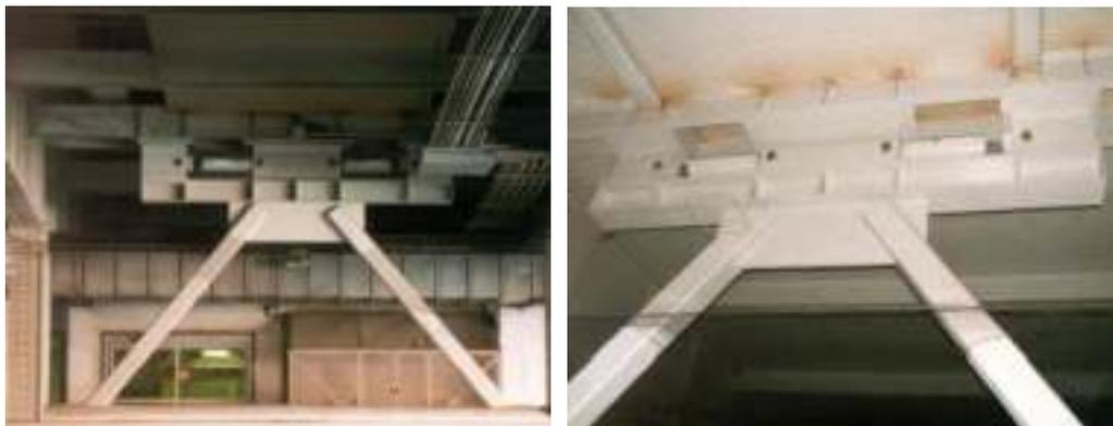
Fig. 1.17 Refuerzo adicional en la disposición Chevron
