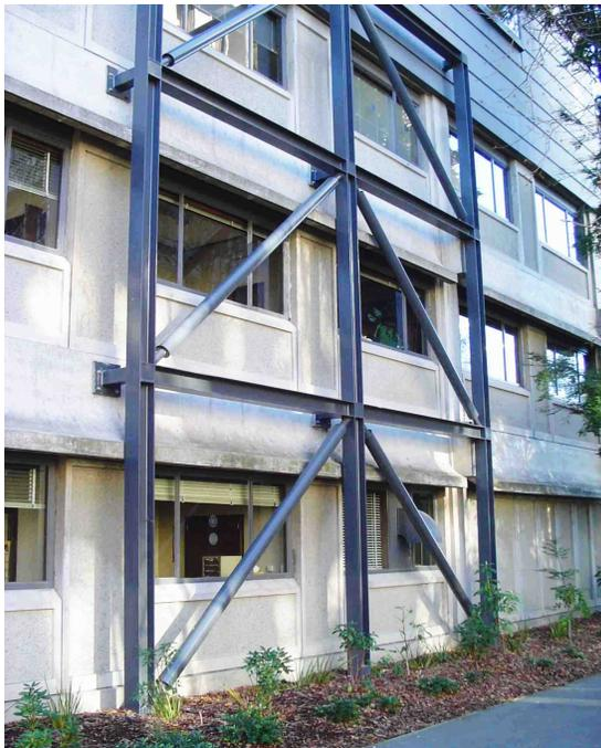
Fig. 2-11. Vista de un pórtico arriostrado utilizado para la rehabilitación de una estructura existente de hormigón armado.
