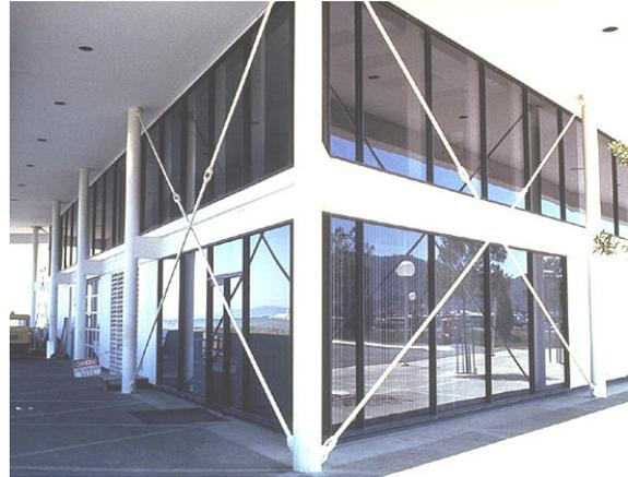
Fig. 4-15. Pórtico arriostrado con tensores en X.
