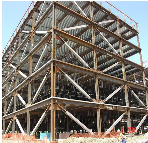
Fig. 2-21. Pórtico de acero con riostras de pandeo restringido.
