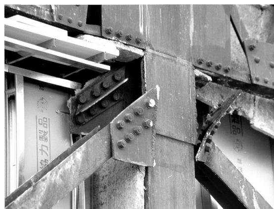
Fig. 1-14. Fractura en una conexión soldada (Naeim, 2001).
