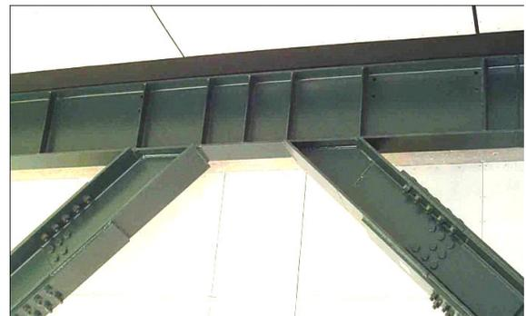
Fig. 2-15. Detalle del enlace en un pórtico con arriostramientos excéntricos
