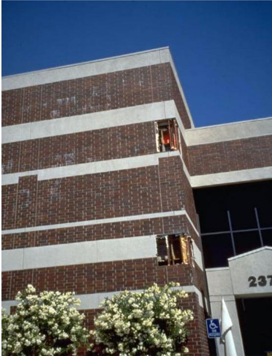
*Fig. 1-8. Edificio bajo inspección para observar los daños causados por el terremoto en las conexiones viga-columna (Earthquake Engineering Research Institute, Slides on the January 17, 1994, Northridge Earthquake, Set I: An Overview).*
