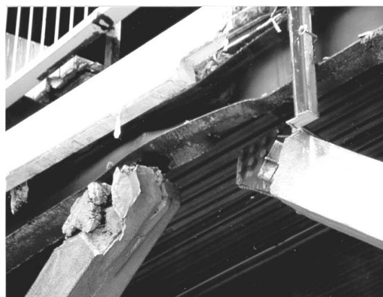
Fig. 1-13. Daño severo en la viga y conexión de un pórtico con arriostramientos en V invertida (Naeim, 2001).
