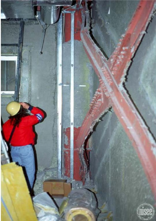
Fig. 1-2. Pandeo de una riostra, terremoto de Hyogoken Nanbu, Japón (Cortesía de National Information Service for Earthquake Engineering, EERC, University of California, Berkeley).
