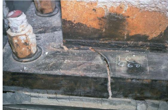
*Fig. 1-9. Fractura en una placa de base de columna de una estructura de pórtico arriostrado (Earthquake Engineering Research Institute, Slides on the January 17, 1994, Northridge Earthquake, Set I: An Overview).*
