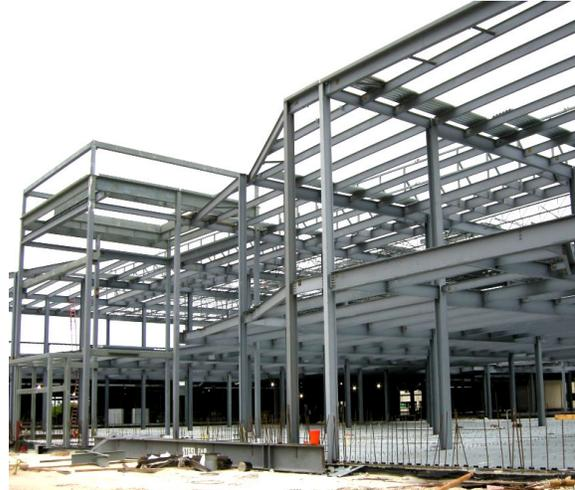
*Fig. 2-6. Vista general de una estructura de pórticos no arriostrados para un edificio comercial.*
