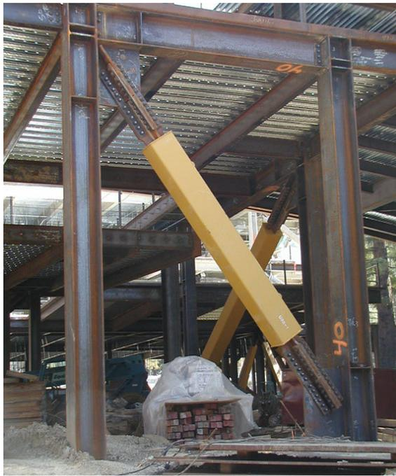
Fig. 2-22. Vista de una riostra de pandeo restringido utilizada en nuevo edificio de la Universidad de California, Berkeley (Cortesía de National Information Service for Earthquake Engineering, EERC, University of California, Berkeley).
