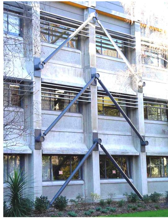
Fig. 2-12. Ejemplo de rehabilitación mediante el agregado de riostras de acero.
