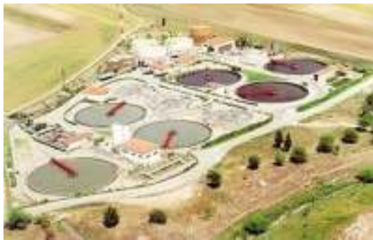
Vista aérea de una EDAR
