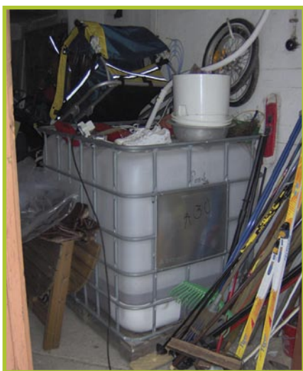
El tanque de la orina en un garaje
