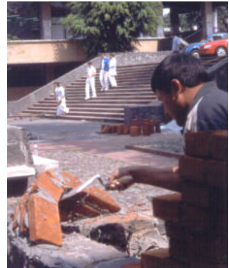
Detalle del inicio de la construcción de la bóveda Ciudad Universitaria, Facultad de Arquitectura, México D.F. 2002
