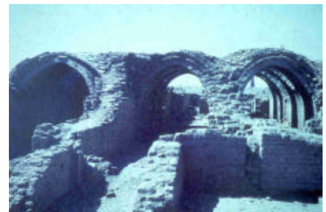
Centro funerario Ramesseum. Egipto Bóvedas núbicas con varias capas de ladrillo de barro sin cocer (adobe)
