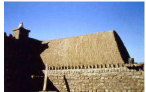
Casa contemporánea en los alrededores de Luxor Nótese el recargue del adobe sobre el muro izquierdo, más alto que los muros de apoyo de la bóveda. (1984)
