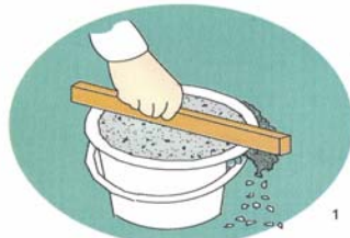
1 Medida de los materiales: agua, piedra y cemento.
