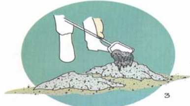
3 En el mezclado a mano se utilizará un tablero o un piso de concreto.
