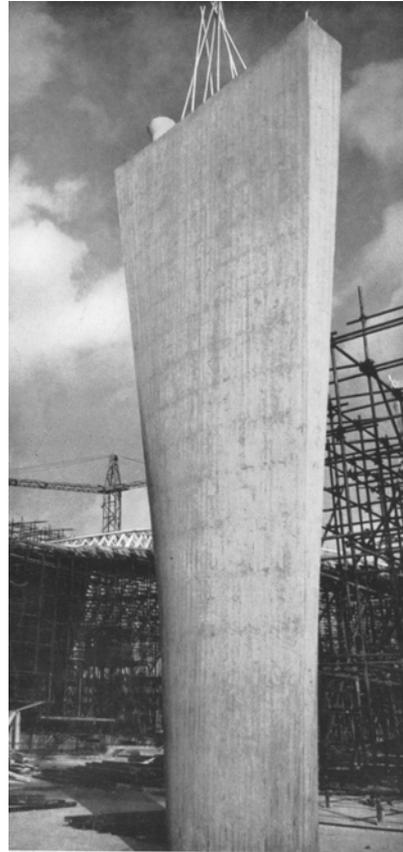
El pilar en construcción muestra también el rastro de los diferentes vertidos sucesivos que corresponden a los tramos en que se ha tenido que fragmentar el encofrado, por secciones transversales.
