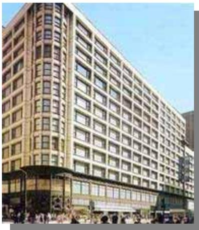
hay que cerrar el edificio con paredes sin función de soporte, paredes que pueden sustituirse con cristal. Cada planta es independiente y se puede compartimentar de formas distintas respetando sólo pilares y jácenas.
