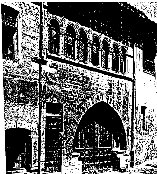
Fig. 6.24 Vivienda medieval de piedra
