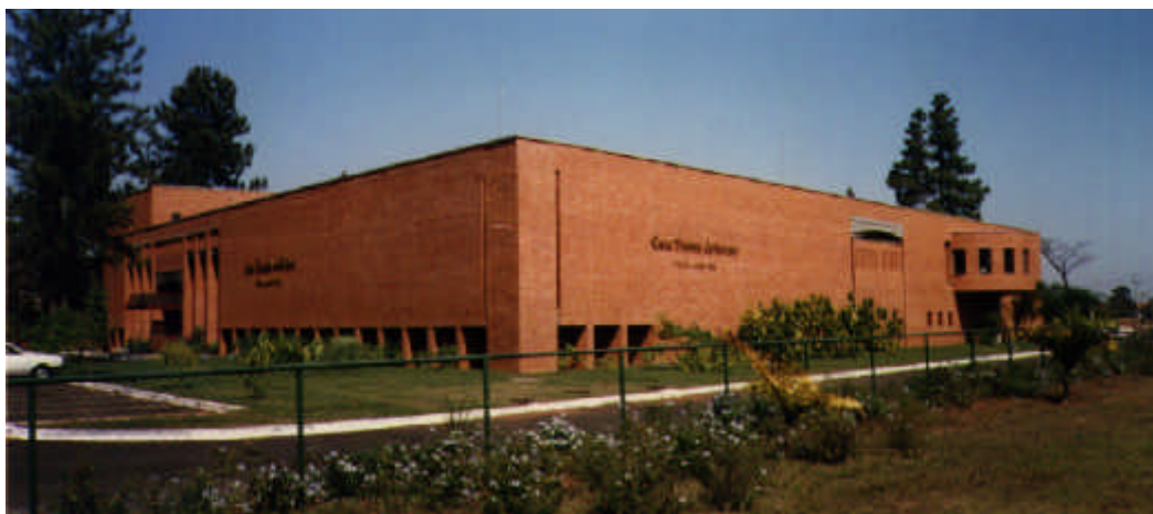
Fig.10.11 Ejemplo de edificio muy asentado
