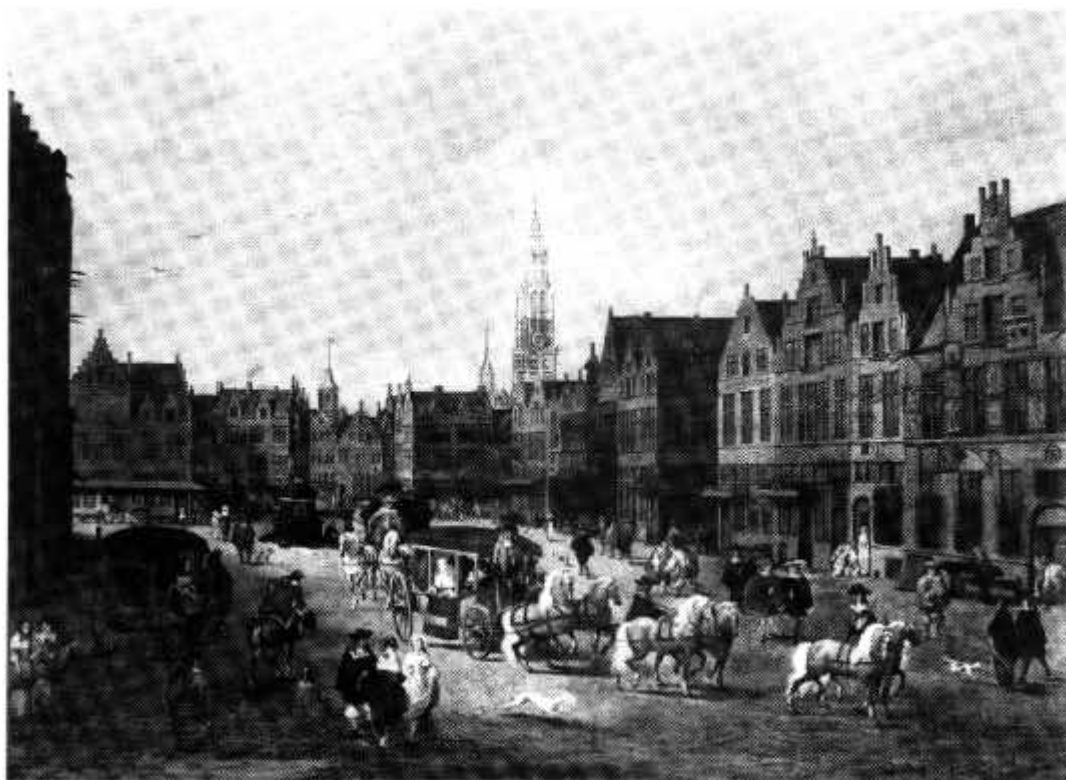
Fig. 6.38 Vivienda urbana entre medianeras
