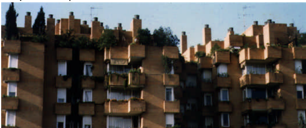
Fig.10.25 Edificios con baja tersura
