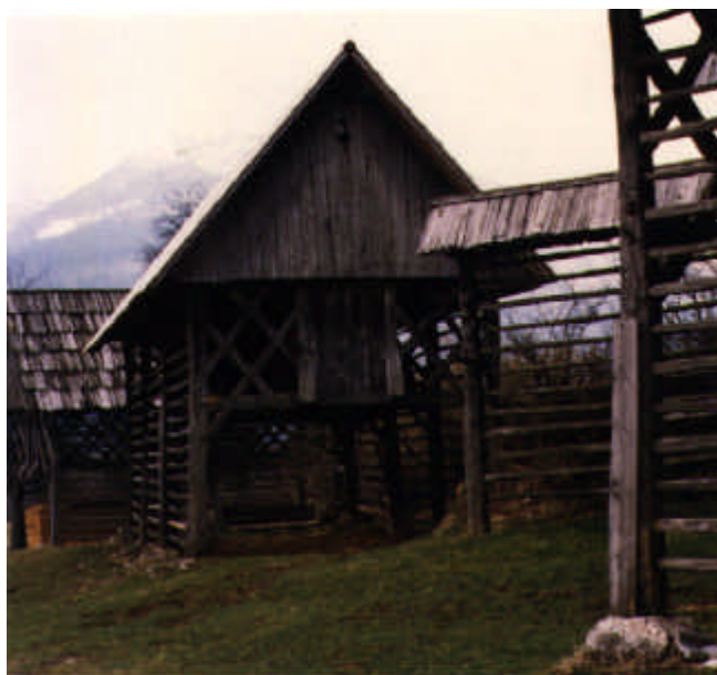
Fig.10.19 Edificio muy permeable al paso del aire
